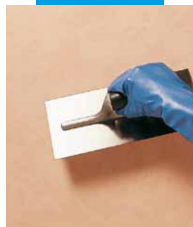
Efecto encáustico: abrillantado de Silexcolor Marmorino con una llana de acero pasada a cero
