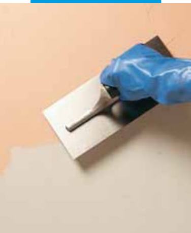
Efecto clásico: aplicación de la primera capa de Silexcolor Marmorino con una llana de acero
