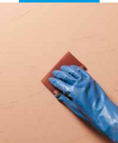
Efecto clásico: lijado de la primera capa de Silexcolor Marmorino con un papel de lijar fino
