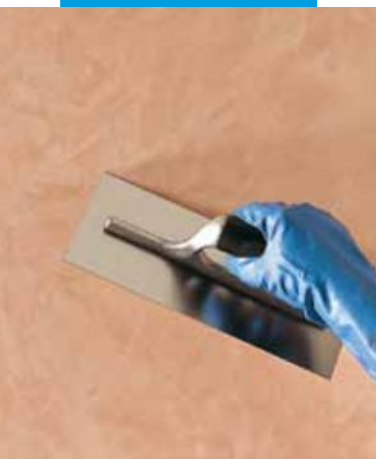
Efecto clásico: abrillantado de Silexcolor Marmorino con llana de acero pasada a cero
