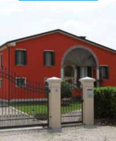
Ejemplo de edificio tratado con Silancolor Tonachino Plus
