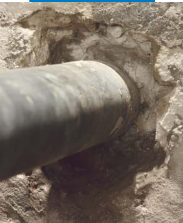
Demolición de la estructura alrededor del tubo
