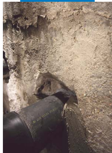
Confinamiento de Mapeproof Swell con Mapegrout T40
