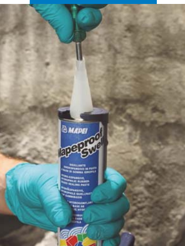
Pinchazo de la membrana de protección de Mapeproof Swell
