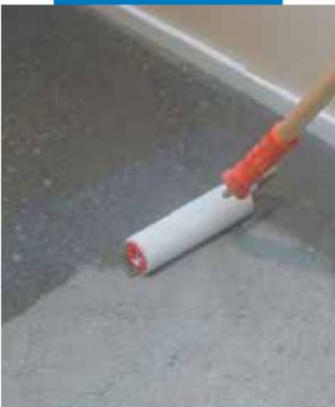
Aplicación de Primer G con rodillo
