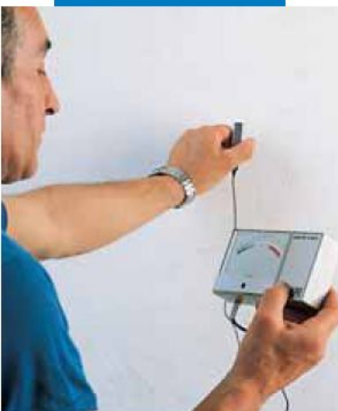
Comprobación de la humedad del yeso
