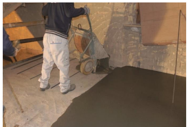
Figura 6.4: Vertido de mortero Planitop HPC Floor.
