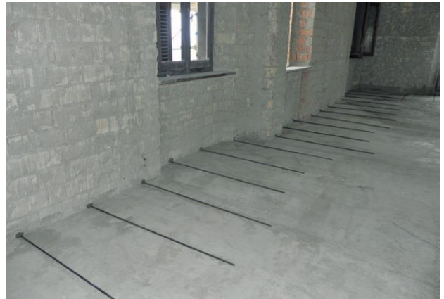
Figura 6.3: Disposición de armaduras en el perímetro.
