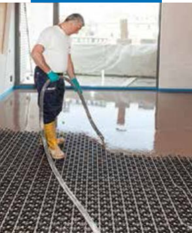
Aplicación de la mezcla hasta saturación del sistema de calefacción radiante de bajo espesor
