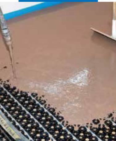
Bombeo y nivelación de Novoplan Maxi
