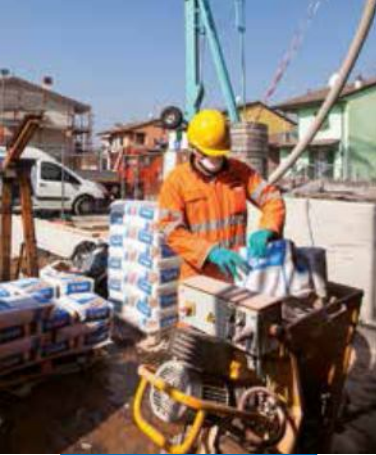
Preparación y bombeo de la mezcla de Novoplan Maxi mediante bomba de mezcla continua
