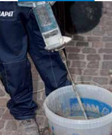
Mezclar Mapestone PFS PCC 2 sólo con agua mediante mezcladora u hormigonera
