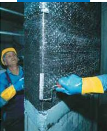
Presión efectuada sobre el tejido con el Rodillo para MapeWrap, para hacer penetrar MapeWrap 31 en el tejido
