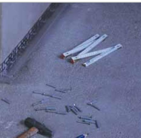
Fig. 5 - Fijación del perfil de partida mediante tacos de expansión
