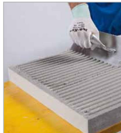
Fig. 6 - Distribución homogénea del adhesivo sobre el reverso del panel aislante
