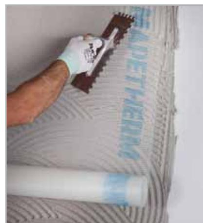
Fig. 14 - Puesta en obra de Mapetherm Net
