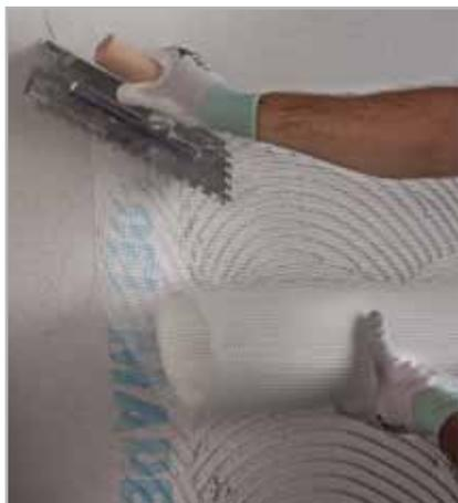
Fig. 15 - Superposición de las mallas al menos 10 cm
