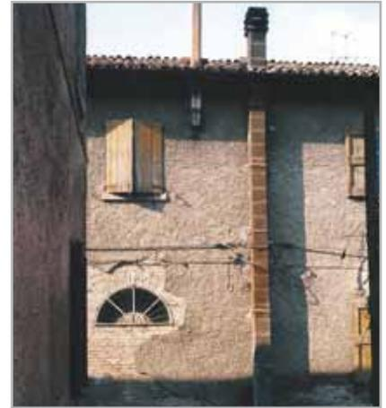
Fig. 1 - Edificio de albañilería afectado por humedad de remonte capilar
