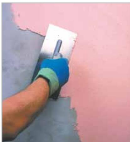
Fig. 16 - Aplicación del revestimiento de acabado
