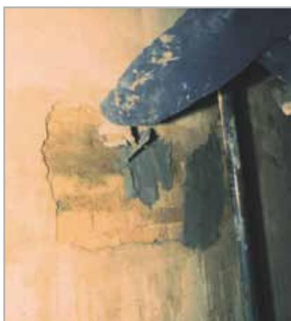
Fig. 3 - Reconstrucción del revoque en fase de desprendimiento con Nivoplan+Planicrete
