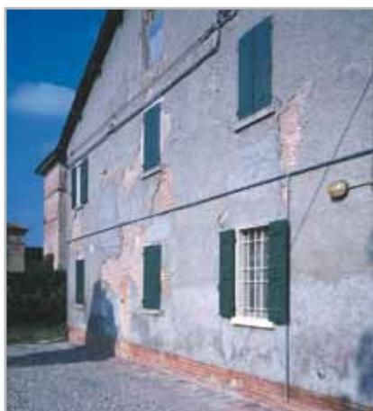
Fig. 2 - Las partes del revoque en fase de esprendimiento deben ser eliminadas antes del encolado de los paneles aislantes
