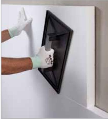
Fig. 9 - Presión del panel mediante fratás
