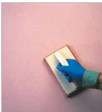
Fig. 17 - Acabado del revestimiento con fratás de esponja
