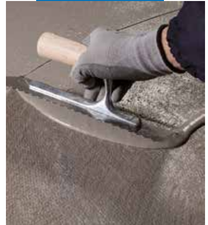
Segunda capa de Mapelastik Turbo sobre la primera armada con Mapetex Sel
