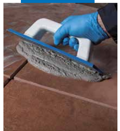
Rejuntado de baldosas con Ultracolor Plus
