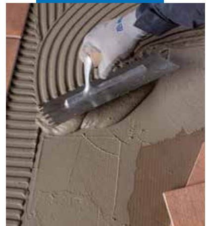
Colocación de baldosas con Elastorapid
