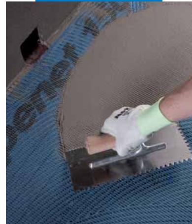
Aplicación de Mapelastic sobre Mapebet 150
