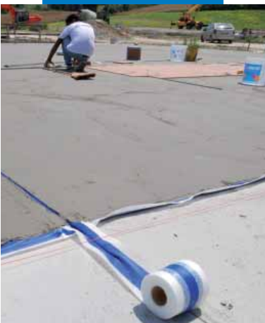
Impermeabilización de los recrecidos con Mapelastic y Mapeband
