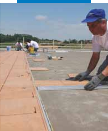
Colocación de cerámica con Kerabond + Isolastic
