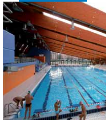
Piscina impermeabilizada con Mapelastic - Piscina Scarioni (Milán) Italia
