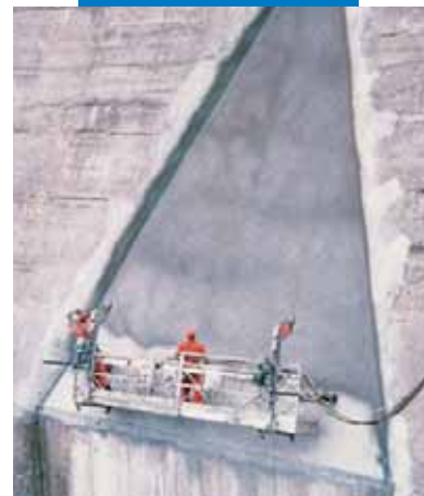
Ejemplo de aplicación por proyección de Mapelastic en una presa
