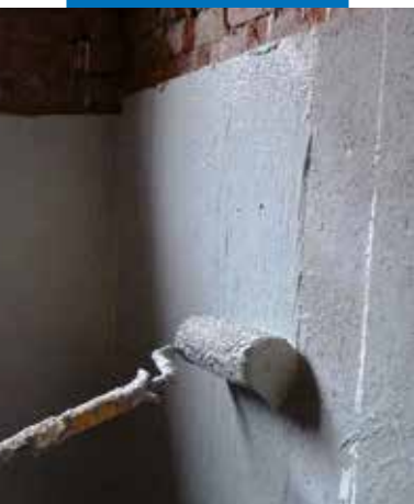
Aplicación de Mapelast Foundation a rodillo, sobre soporte previamente regularizado con Planitop HDM Maxi
