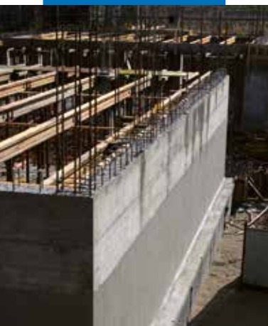
Muro de contención de tierras impermeabilizado después del hormigonado con Mapelast Foundation
