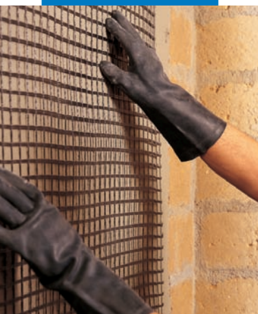
Colocación de Mapegrid G 220
