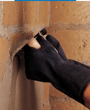
Aplicación de la primera capa de Planitop HDM
