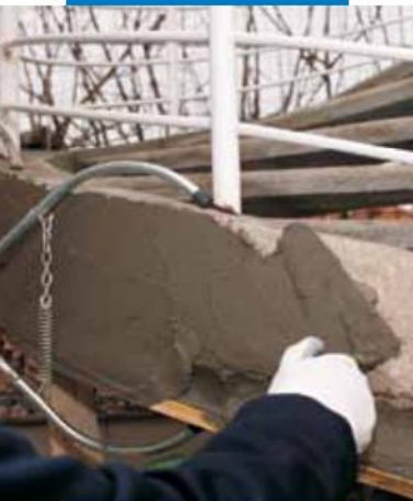
Aplicación mediante paleta de Mapegrout 430
