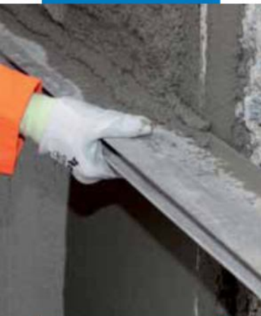
Reglado de Mapegrout 430
