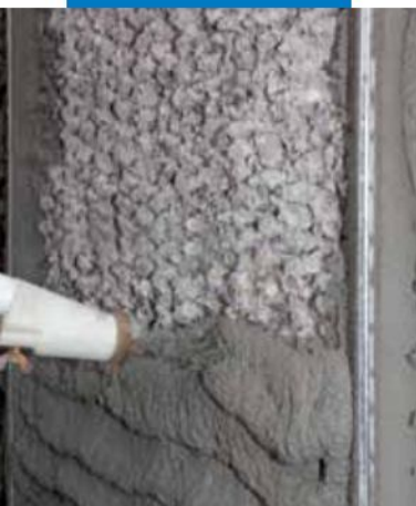
Aplicación por proyección de Mapegrout 430
