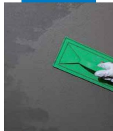
Fratado de Mapegrout 430
