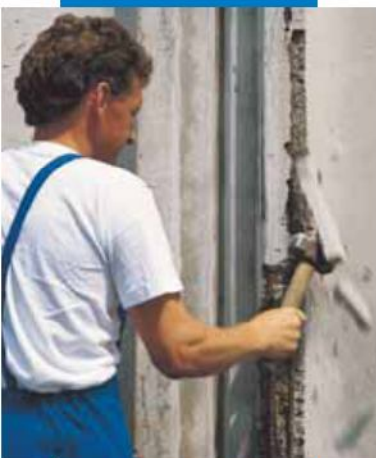
Demolición del hormigón degradado
