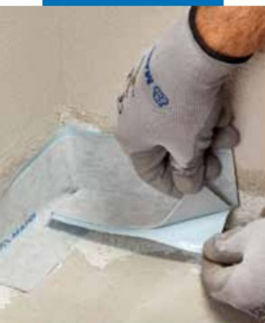
Aplicación de Mapeband SA en los ángulos
