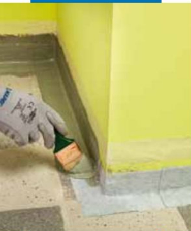
Aplicación de Mapeband SA sobre recocado
