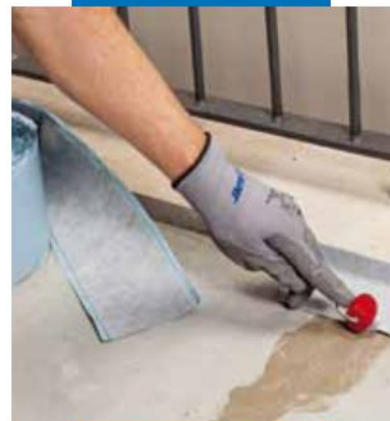
Aplicación de Mapeband SA en las aristas
