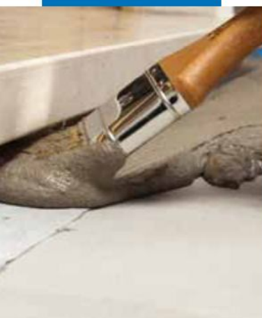
Aplicación de Mapeband SA en puntos de difícil acceso como en subumbrales
