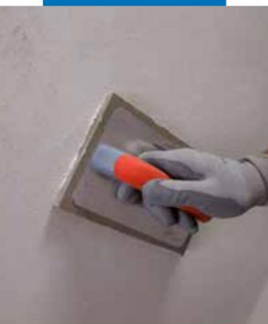
Acabado con fratás de esponja de Mape-Antique FC Civile
