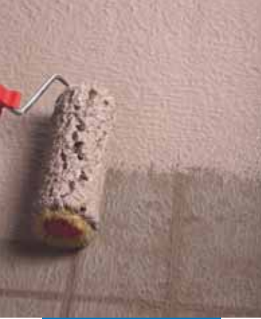
Impermeabilización de muro de cimentación a rodillo
