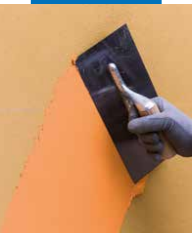
Aplicación de Mapetherm Flex RP
