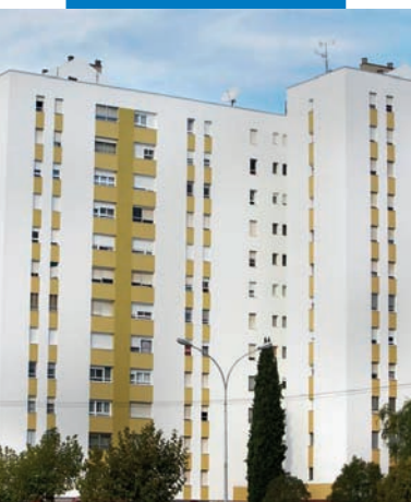
Torrelago - España Aislamiento Térmico por el Exterior realizado con Mapetherm AR1 GG
