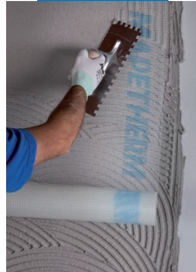
Ejecución del enlucido armado con el refuerzo de la malla Mapetherm Net
