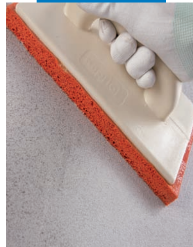
Acabado del enlucido con fratas de esponja
