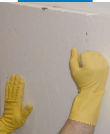
Presionado de los paneles, después de su colocación, para asegurar una buena adhesión al soporte
