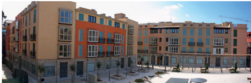
Aislamiento térmico por el exterior en edificios plurifamiliares Sa Gerreria – Palma de Mallorca (Balears)
