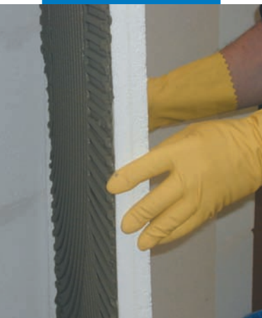
Colocación de paneles termoaislantes
