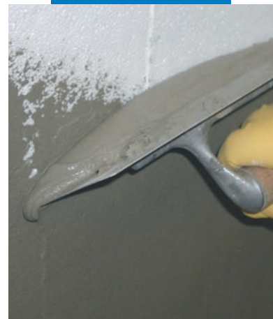
Enlucido de paneles termoaislantes: extendido de Mapetherm AR1
