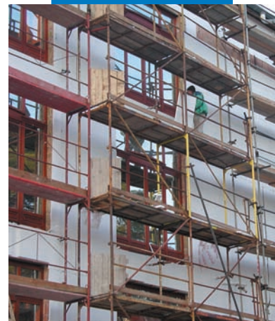
Encolado de las placas aislantes a la fachada con Mapetherm AR1
