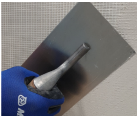
Enlucido con malla de fibra de vidrio álcali resistente
