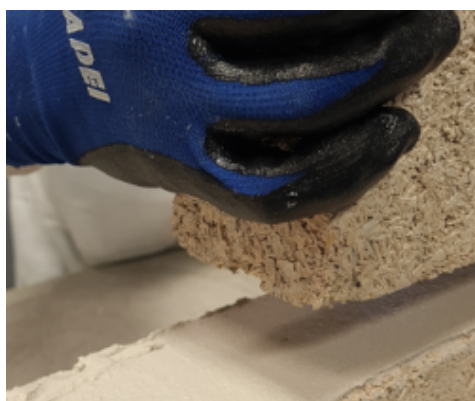
Construcción de albañilería con bloques de cal y cáñamo
