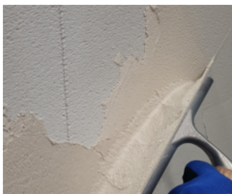
Enlucido de bloques de hormigón celular
