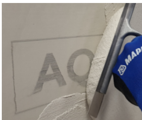
Enlucido de paneles de cemento
