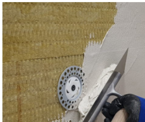
Enlucido de paneles de lana de roca
