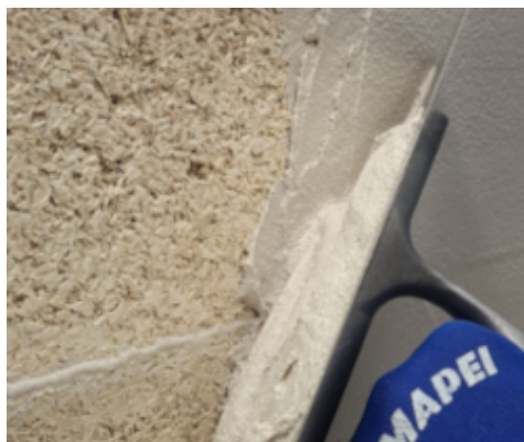
Enlucido de paneles y bloques de cal y cáñamo
