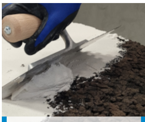
Aplicación de Mape-Antique NHL ECO Raso Fix como adhesivo sobre paneles de corcho
