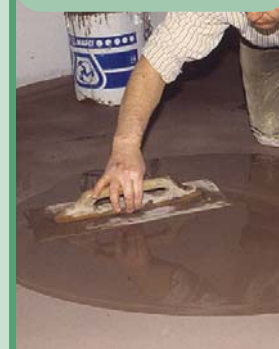
Nivelación realizada con ULTRAPLAN MAXI
