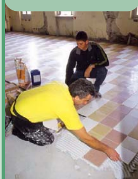
Colocación de las baldosas
