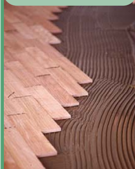
Colocación de parquet con LIGNOBOND
