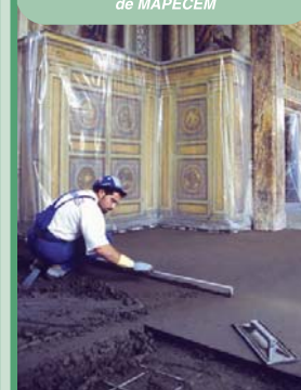
Regleado del recrecido de MAPECEM
