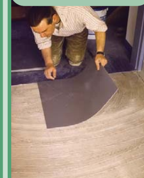
Colocación de PVC
