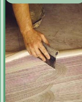
Aplicación del adhesivo con ADESILEX V4
