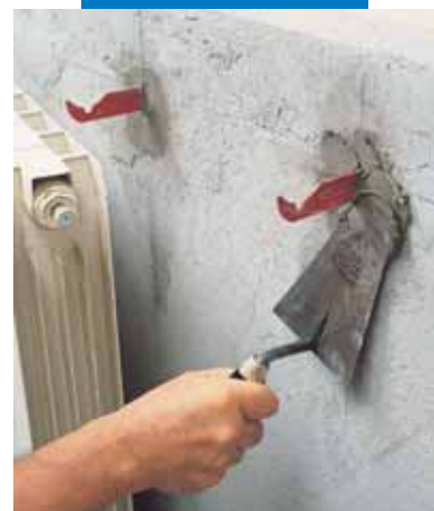
Colocación de garras para radiadores con Lampocem
