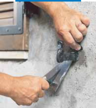
Colocación de grapas para ventanas con Lampocem
