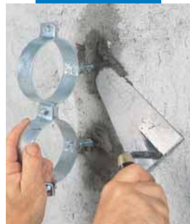
Fijación de abrazaderas para cañerías con Lampocem
