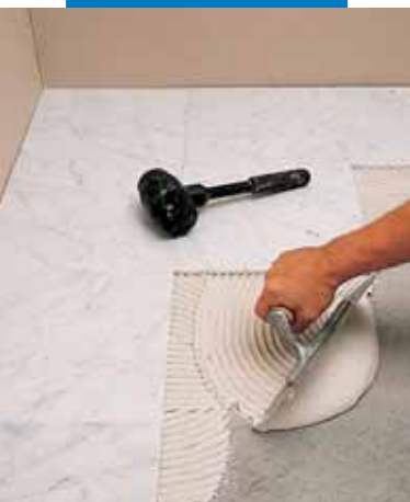
Colocación de mármol de Carrara blanco con Keraquick blanco
