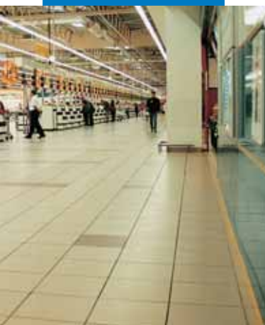
Ejemplo de colocación con Keraquick en un supermercado Auchan - Sosnowiec (Polonia)
