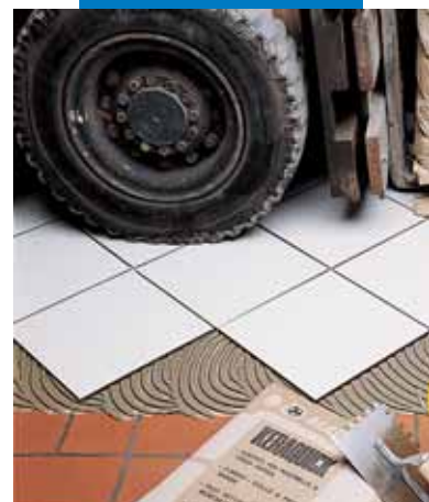
Rápida reconstrucción sobre pavimento industrial
