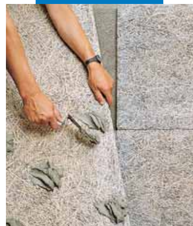
Colocación de paneles aislantes pesados
