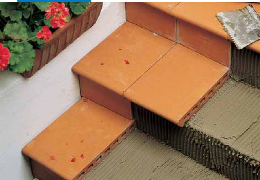
Rápida reconstrucción de una escalera
