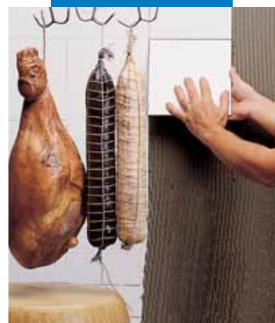
Reparación de cámara frigorífica
