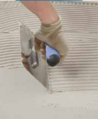
Aplicación de Keraflex Extra S1 con llana dentada
