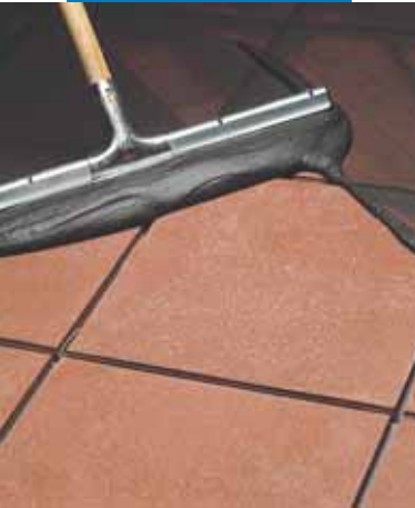
Rejuntado de pavimento de terracota con rasqueta
