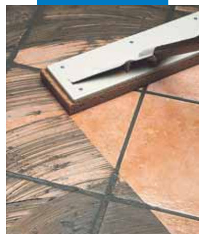
Limpieza de monococción con cepillo de esponja
