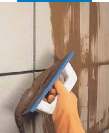
Rejuntado de revestimiento externo con llana
