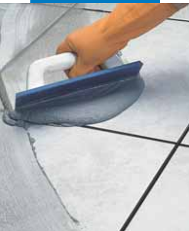
Rejuntado de pavimento de cerámica con llana de goma
