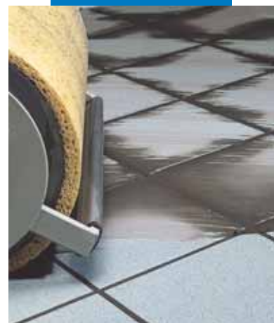
Acabado de pavimento con máquina
