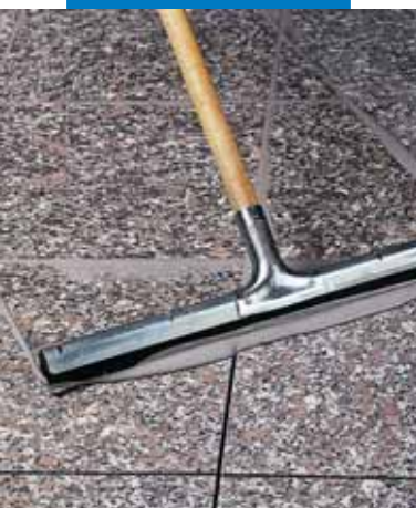
Rejuntado de pavimento de granito prepulido con rasqueta
