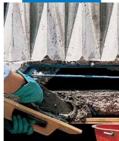
Ejemplo de reparación de un balcón con Mapegrout T40, "fase inicial"
