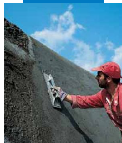
Acabado de Mapegrout T40 con fratas
