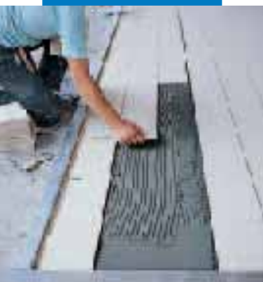
Colocación mármol Jura con Granirapid blanco
