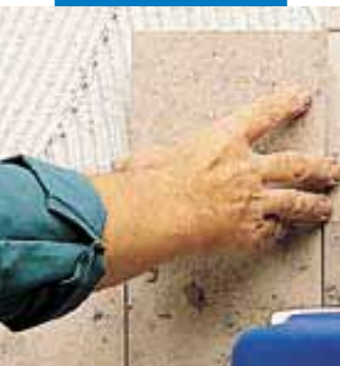
Colocación mármol Jura con Granirapid blanco
