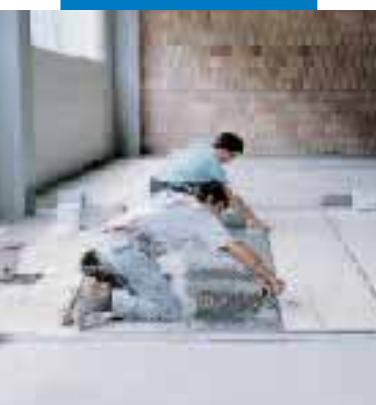
Colocación de gres porcelánico en ambiente industrial
