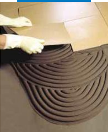
Colocación de gres porcelánico sobre solera impermeabilizada con Mapelastic
