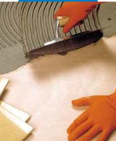
Colocación de gres porcelánico con Elastorapid, sobre un soporte de contrachapado marino
