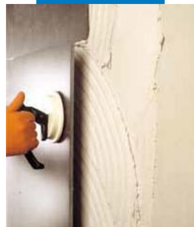
Colocación de gres porcelánico de gran formato con Elastorapid, en fachada, sobre hormigón
