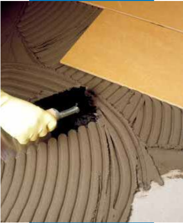
Extensión con llana dentada de Elastorapid sobre solera cementosa
