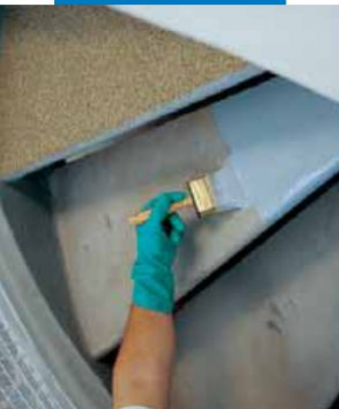
Aplicación de Mapecoat I 24 sobre hormigón
