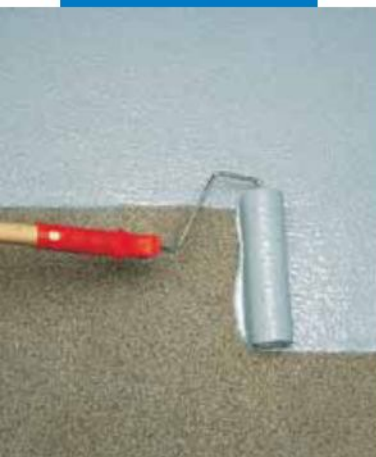
Aplicación de Mapecoat I 24 a rodillo
