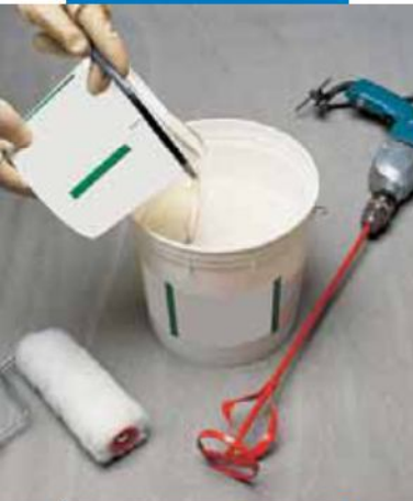
Mezclado del componente B con el componente A
