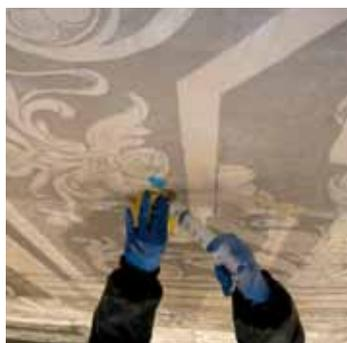
**Aglomerante hidráulico con cargas, superfluido, resistente a las sales, a base de cal y Eco-Puzolana, para la consolidación de muros, revoques y frescos, mediante inyección**
