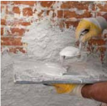
**Mortero transpirable resistente a las sales, a base de cal y Eco-Puzolana, para aplicar antes de revocos deshumidificantes, de fondo y estructurales**
