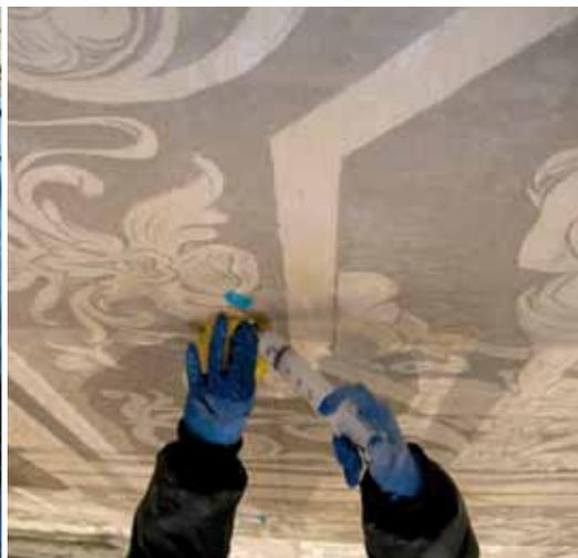
*Inyección de consolidación de un revoque*
