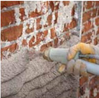
Revoque de fondo transpirante, a base de cal hidráulica natural y Eco-Puzolana, para aplicar sobre muros existentes, incluso de valor histórico, o de nueva construcción
