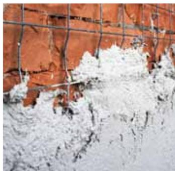
Mortero para revocos y albañilería, de elevadas prestaciones mecánicas, a base de cal hidráulica natural y Eco-Puzolana, particularmente indicado para realizar revocos “armados” y morteros de fábrica de albañilería
