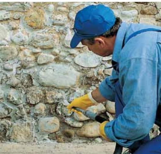
*Inyección de consolidación de albañilería en seco*
