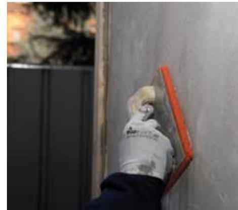
Fratasado de un revoque deshumidificante
