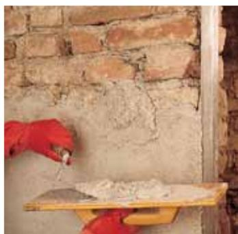
**Mortero de revoque macroporoso, resistente a las sales, a base de cal y Eco-Puzolana, de color claro, para realizar revocos deshumidificantes**
