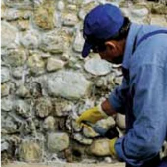
**Aglomerante hidráulico con cargas, resistente a las sales, a base de cal y Eco-Puzolana, para la consolidación de muros, mediante inyección**
