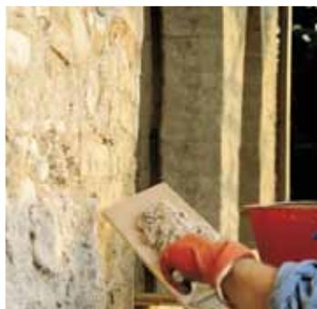
**Mortero macroporoso, resistente a las sales, a base de cal y Eco-Puzolana, de color de arcilla cocida, para realizar revoques deshumidificantes**
