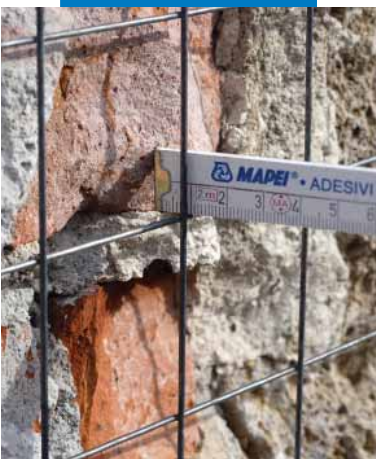
Verificación de la distancia entre la malla y el soporte
