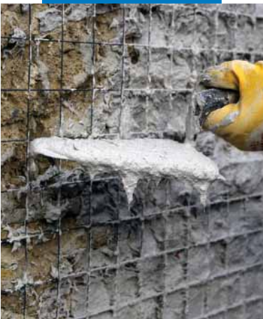
Aplicación de Mape-Antique Rinzaffo sobre un muro mecánicamente débil
