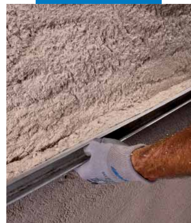
Regleado de Mape-Antique Strutturale NHL
