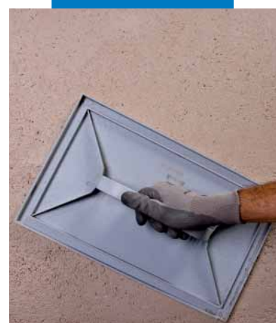
Fratasado de Mape-Antique Strutturale NHL
