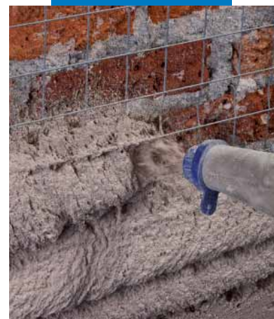
Aplicación por proyección de Mape-Antique Strutturale NHL
