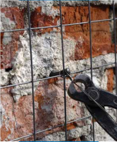
Fijación de la malla galvanizada al muro
