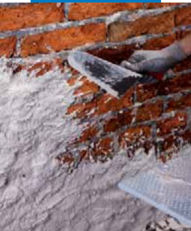
Aplicación de Mape-Antique Rinzaffo
