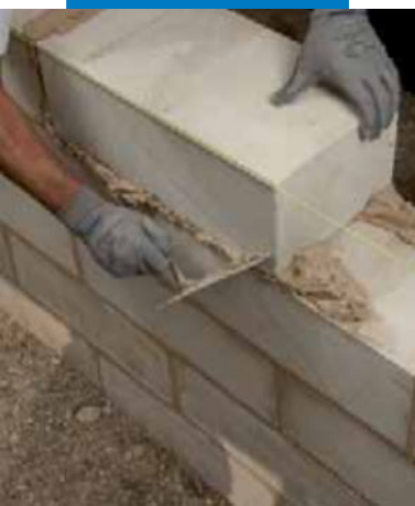
Eliminación del mortero en exceso
