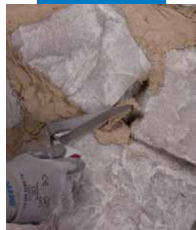
Retacado de las juntas de un muro de albañilería de piedra
