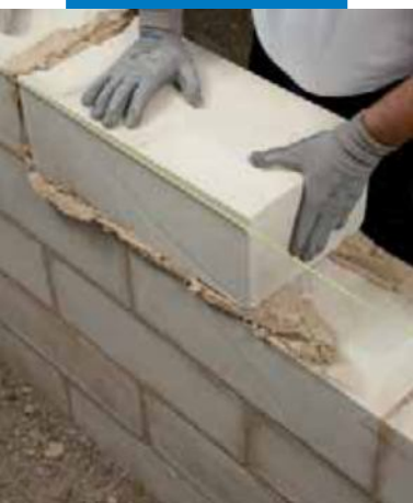
Colocación de bloque de piedra de Lecce
