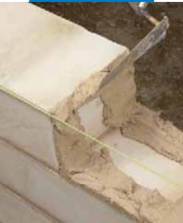
Aplicación de Mape-Antique Allettamento
