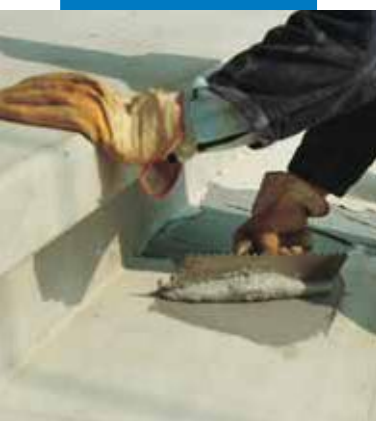
Extendido de Adesilex PG1 con llana dentada para el encolado de peldaños prefabricados
