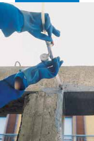
Aplacado metálico con Adesilex PG1
