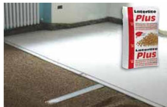
La solución prevé la realización, según el espesor para recrecer, de una o dos capas ligeras de recrecido y solera, para posterior colocación del solado mejorando las características de aislamiento del forjado y permitiendo la integración de conductos de instalaciones.
