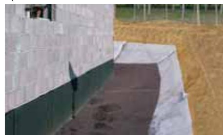
La solución prevé la formación de una capa aislante térmica de elevada resistencia mecánica entre el terreno y las estructuras de cimentación del edificio, capaz de evitar la subida capilar de la humedad. Permite realizar aislamientos continuos por debajo de las cimentaciones sin puentes térmicos. La solución se puede completar con una o varias capas de solera o reecido ligero (Fichas R1 – R2 – R4).
