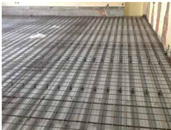
La solución prevé la realización de un nuevo forjado estructural de hormigón ligero estructural (losa, forjado unidireccional o bidireccional con o sin elementos de aligeramiento).
