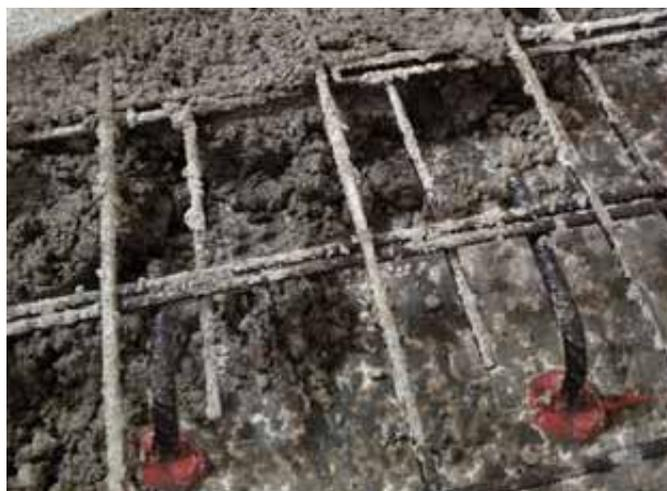
La solución prevé la realización de un nuevo forjado estructural formado por una chapa grecada sobre la que se vierte una losa colaborante de hormigón ligero armado (losa mixta). Según las características y las necesidades de uso (espesores, cargas, etc.) la solución se puede completar con una o varias capas de solera o recredido ligero (véanse las fichas R1 – R2 – R4).
