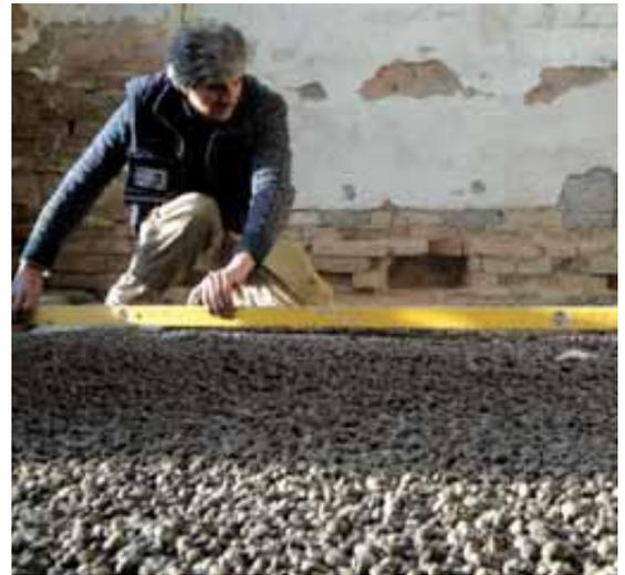
Rehabilitación de planta baja: Extendido de la capa de Laterlite Plus 8-20 en seco.
