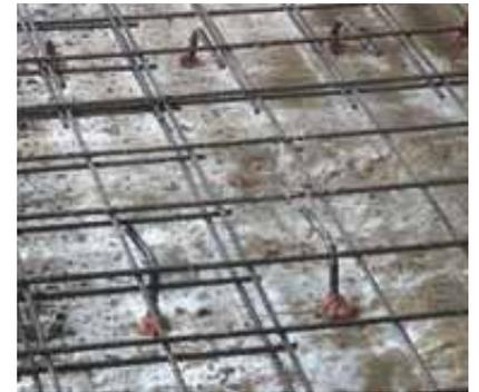
Conector mecánico artesanal fijado con resina.
