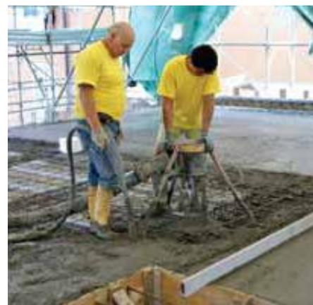
Bombeo con transportadora de mortero: trípode terminal de la manguera.
