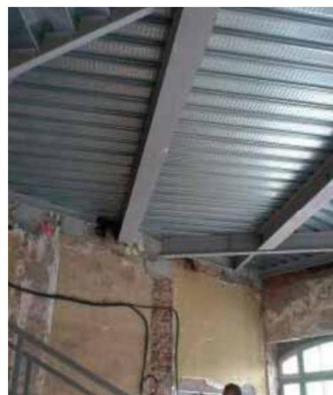
Rehabilitación: Sustitución del antiguo forjado con nueva losa mixta acero-hormigón ligero – ETSI Minas, Madrid – España.
