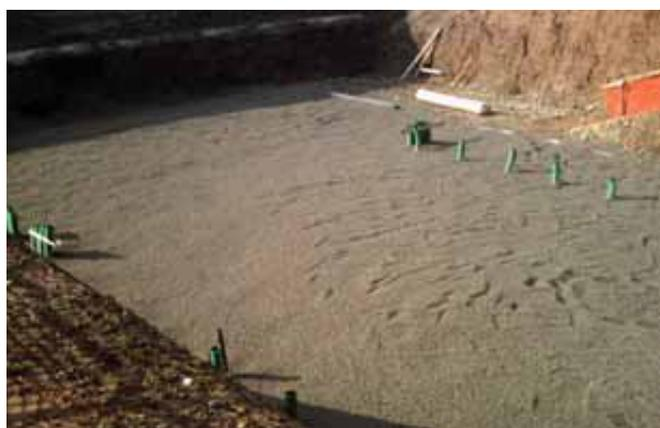
Laterlite Plus en seco puesta en obra antes del vertido de la losa de cimentación.
