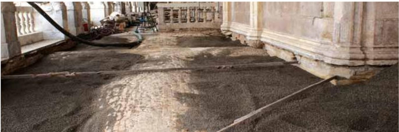
La solución prevé la realización de un sistema de solera en seco formado por una capa de regularización granular muy ligera y aislante de Arcilla Expandida granular (que permite integrar los conductos de las instalaciones) sobre la que se colocan las placas rígidas que sirven como soporte del solado.
