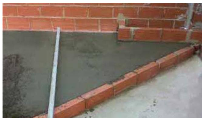
Por encima del forjado de cubierta plana, la solución prevé, sobre la impermeabilización, la realización de una solera ligera destinada a recubrirse con pavimento.
