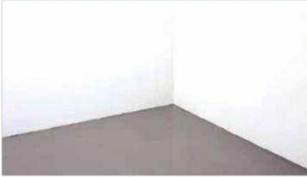
La superficie destinada al vertido de la capa de revestimiento tiene que estar limpia, seca y libre de cualquier impureza, especialmente de pedacitos de espuma de poliestireno, que puede mezclarse con la mezcla de mortero y afectar a su aspecto final
