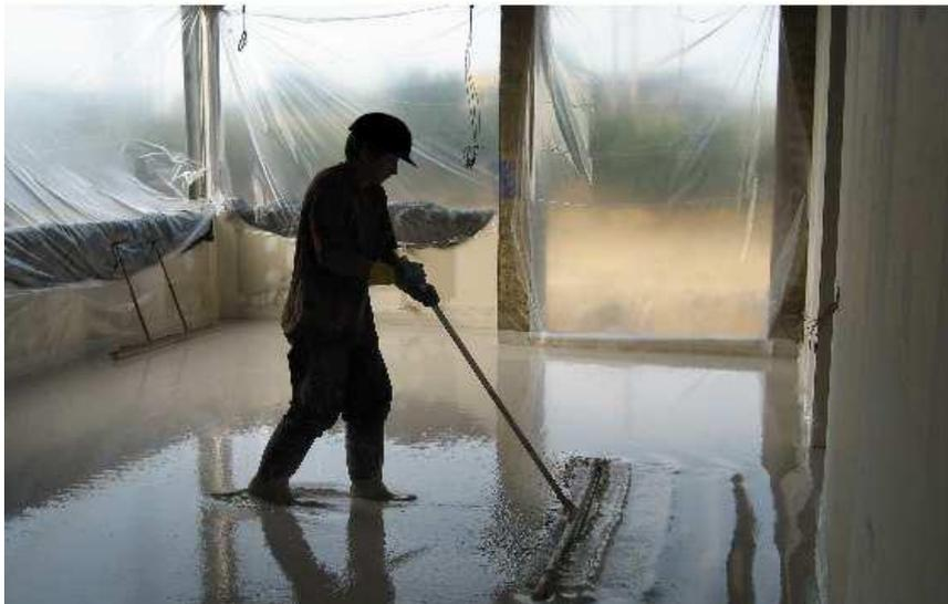
En primer lugar, la capa de revestimiento debe ser tratada mediante la aplicación de barras en una sola dirección de tal modo que las Barras estén totalmente sumergidas dentro de la mezcla casi tocando el suelo de apoyo. El segundo ciclo de tratamiento con barras se debe realizar en dirección perpendicular a la primera fase del tratamiento. La tercera fase del tratamiento de la capa mediante barras debe hacerse sólo en la superficie, sin la inmersión completa de las barras
