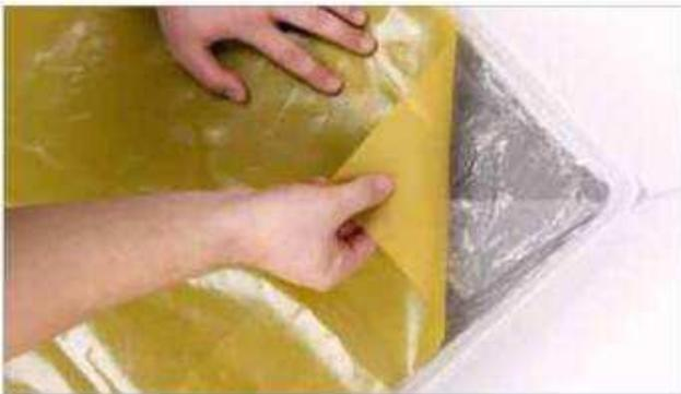
La lámina debe ser cuidadosamente instalada en las esquinas con la aplicación de una banda perimetral de dilatación. También se puede colocar elevando la lámina por las paredes unos 10 cm.
