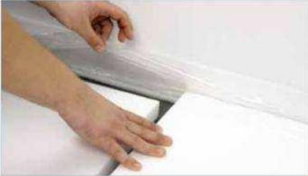
La lámina que constituye la capa de la pared adyacente tiene que ser colocada correctamente sin pliegues ni irregularidades. Los bordes deben estar protegidos contra la posibilidad de entrada de la mezcla líquida por debajo de ella (se recomienda crear al menos 10 cm de juntas en las zonas donde dos secciones son adyacentes entre sí y cuyos bordes deben estar protegidos con la aplicación de cinta adhesiva)
