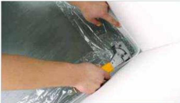
La banda perimetral de dilatación tiene que estar aplicada de tal manera que permita su formación sin restricciones.
