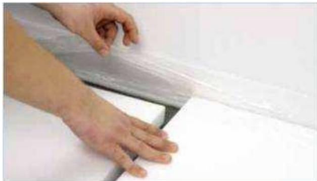
El proceso de aplicación de la banda perimetral de dilatación debe realizarse con un método que limite la formación de espacios vacíos en la pared adyacente, que también están presentes entre las capas de espuma de poliestireno, a fin de eliminar cualquier movimiento innecesario entre las capas
