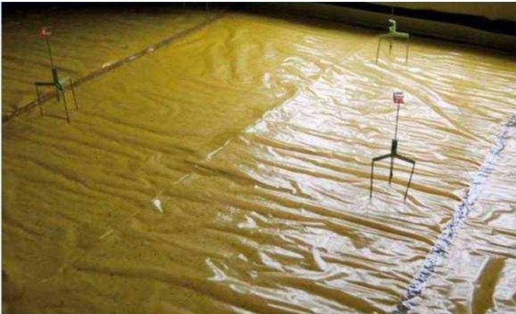
Con el fin de obtener un nivelado y una superficie plana de Agilia Suelo A, se debe garantizar un nivelado apropiado de la superficie con la aplicación del dispositivo de nivelación.
