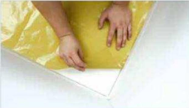
La lámina que constituye la sección de la división debe ser colocada sin ningún tipo de curvas y pliegues innecesarios y sus bordes deben estar protegidos contra la posibilidad de que se salga la mezcla líquida de debajo de ella (se recomienda crear al menos 10 cm de juntas en las zonas donde dos secciones separadas de aluminio son adyacentes entre sí y cuyos bordes deben estar protegidos con la aplicación de cinta adhesiva)
