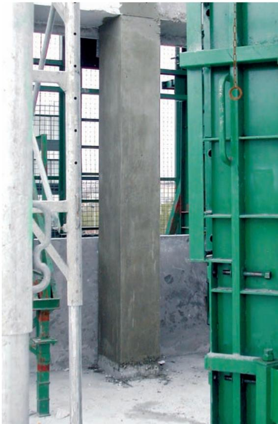
Chronolia™ es un hormigón que mantiene su trabajabilidad hasta 2 horas después de su fabricación y alcanza altas resistencias iniciales que permiten acelerar de manera importante el desencofrado de los elementos de construcción. Además utiliza una avanzada tecnología que permite una colocación más fácil que la del hormigón convencional.
