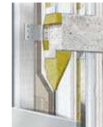
Montante doble + placa intermedia
