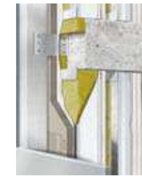
Montante doble + placa intermedia
