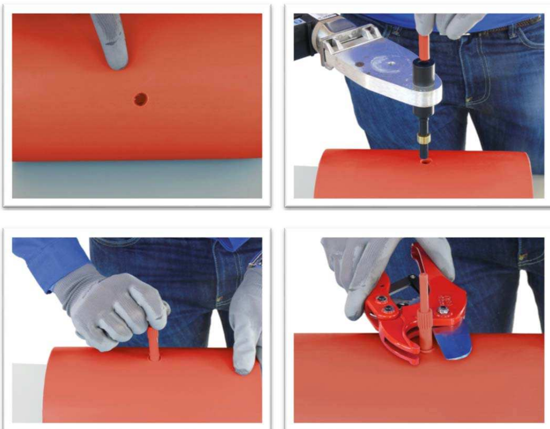
Figura 6. Reparación con varilla
