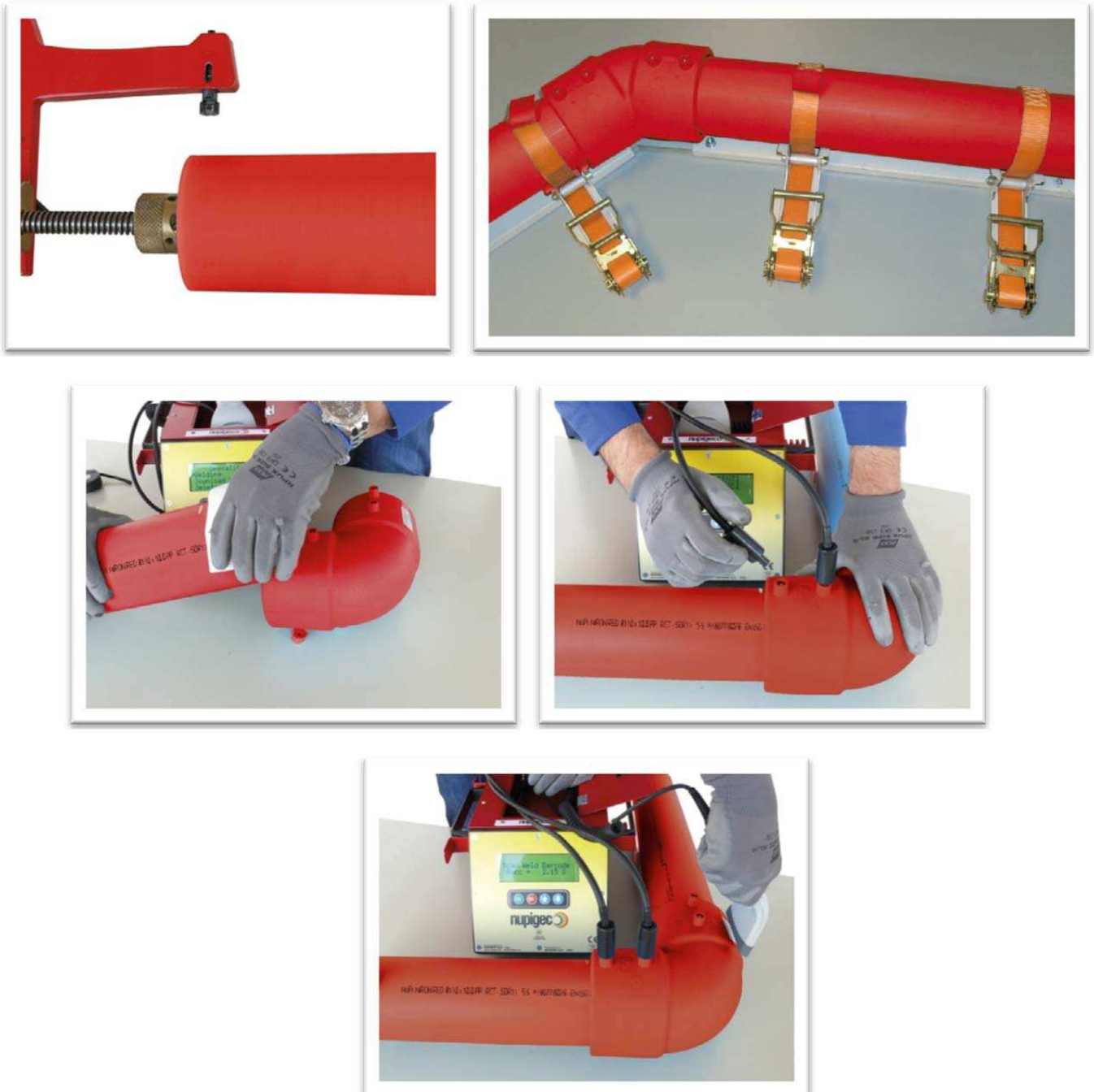
Figura 4. Soldadura con electrofusión
