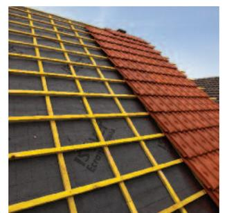
La solution pour une isolation minimale en rénovation en 1 couche, sans modification de la hauteur de la toiture.
