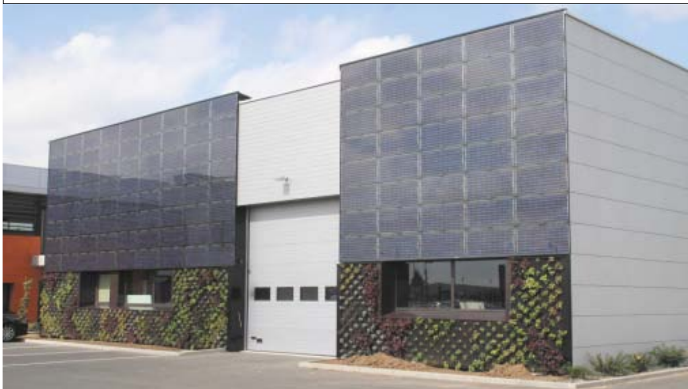
Isofaçade 32 200 mm (2 x 100 mm) avec bardage végétalisé et photovoltaïque Siège social Isore Bâtiment (bâtiment basse consommation) - Architecte : Archiligne
