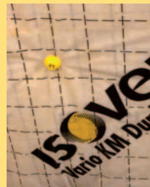
Pose de la membrane d'étanchéité à l'air Vario Duplex
