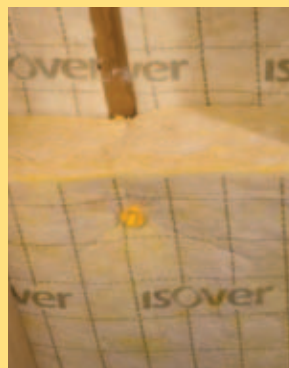
Mise en place de la 2 de couche d'isolant Isoconfort
