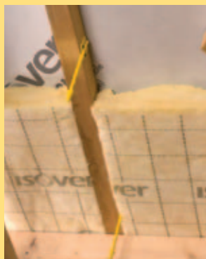
Mise en place de la 1 re couche d'isolant Isoconfort
