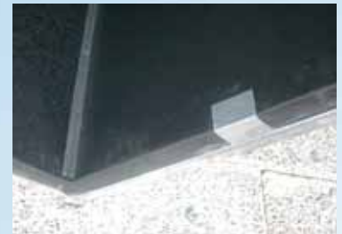
Patte d'arrêt soudée au conduit.
