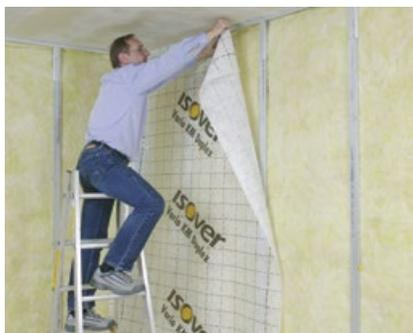
Una vez fijados los perfiles Optima UST al suelo y al techo, se colocan los perfiles Optima 240 antes de aplicar VARIO KM Duplex UV.
