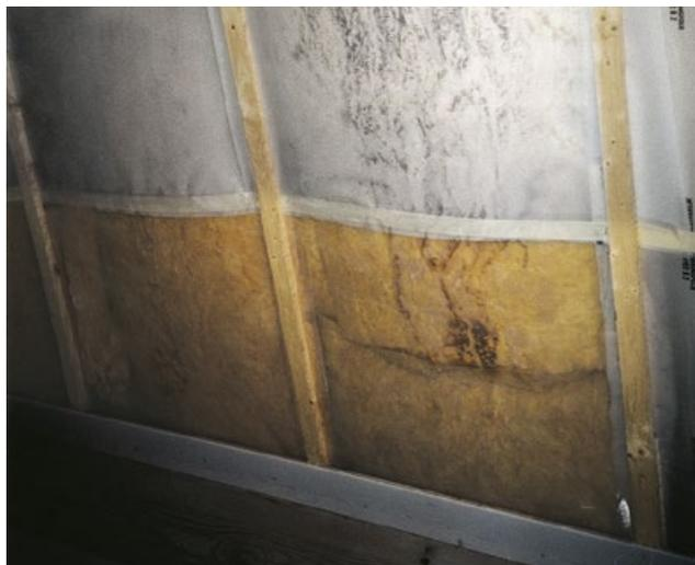
Daños debidos a la inclusión de madera húmeda combinada con un retardante convencional de vapor de agua.
