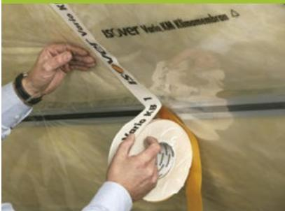
Con subestructuras de perfilera VARIO KM Duplex UV se fijan con VARIO DS. En el caso de las subestructuras de madera, VARIO KM Duplex UV se grapa directamente al marco de madera.
