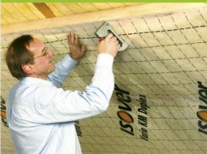
VARIO KM Duplex UV es una membrana especialmente laminada extremadamente resistente al desgarro. Por este motivo, se tiende sobre el aislamiento sin holgura. Las marcas de guiado punteadas facilitan enormemente la instalación.
