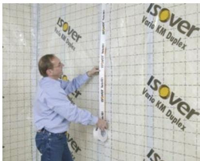
VARIO KM Duplex UV tiene un solape de 10-15 cm y una unión estanca creada usando VARIO KBI. Las uniones con la pared y el suelo se realizan usando VARIO DS, estanqueizando la estructura.
