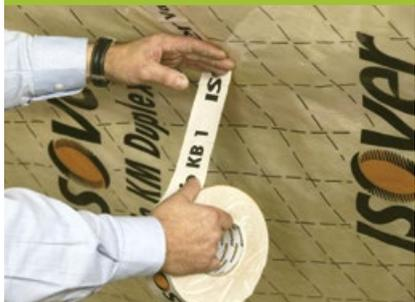
Las juntas de la membrana VARIO KM Duplex UV se solapan en 10-15 cm y se unen con VARIO KB1.
