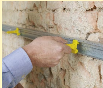
. Colocar los Clips OPTIMA 2 .
