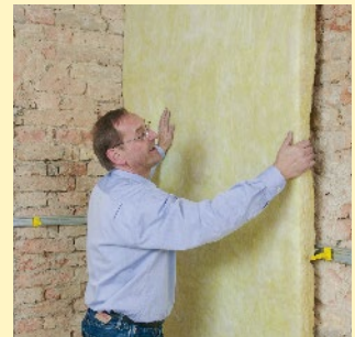
. Colocar la Lana Mineral ISOVER: CO 0 2 y los Clips OPTIMA 2 .
