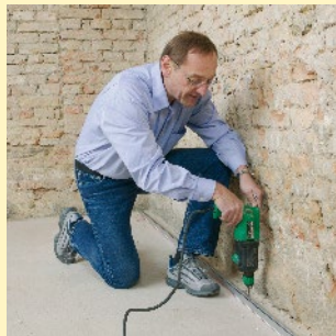
. Fijación de los perfiles OPTIMA ST.
