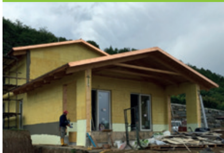
Vivienda unifamiliar de consumo casi nulo
